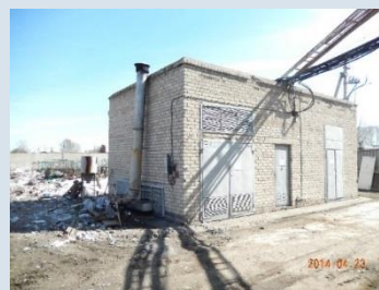
3. Трансформаторная подстанция – 49,8 м2
